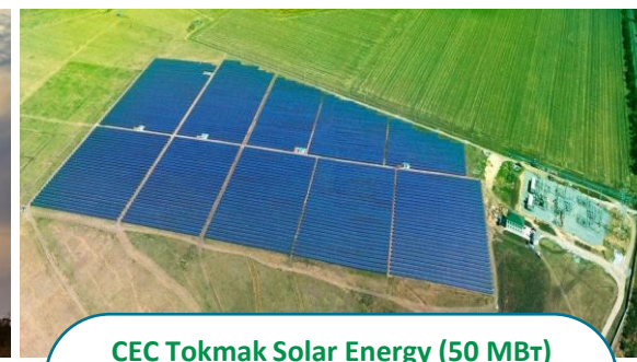
СЕС Tokmak Solar Energy (50 МВт) (Запорізька обл., м. Токмак)
