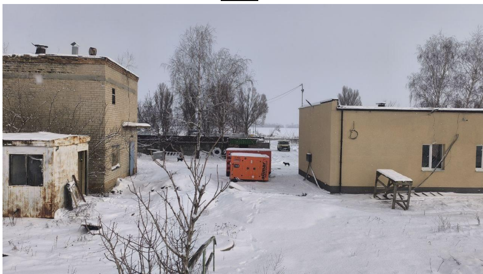
Фото 7. Фотографія оточуючої ділянки місця розташування пункту спостереження за станом атмосферного повітря ПС № 2 (вид на схід).
